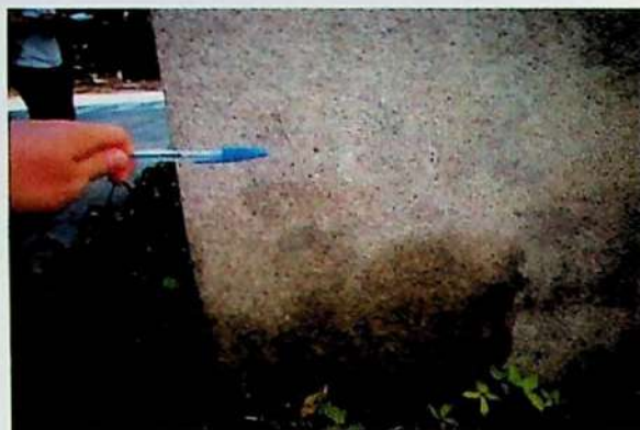
Figura 2: Mancha de umidade.
