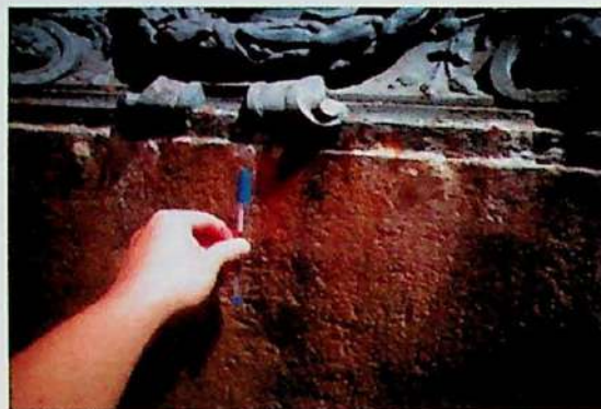
Figura 2: Mancha amarelada e concreção.
