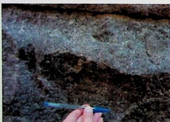
Figura 3: Destacamento e perfuração por talhadeira.
