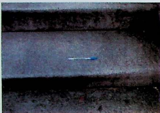
Figura 1: Desgaste abrasivo incipiente do piso por passagem de pedestre.
