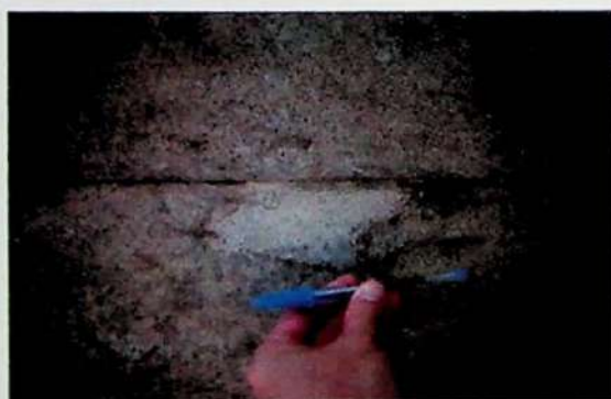
Figura 4: Destacamento (esquerda) e restauração com argamassa (centro).
