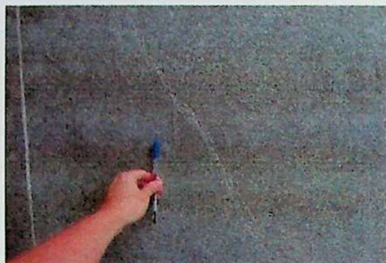
Figura 2: Fissura.
