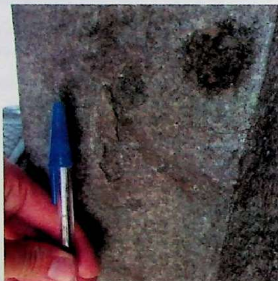
Figura 3: Destacamento e mancha de óleo.
