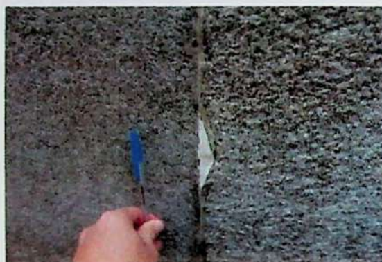
Figura 2: Restauração com argamassa.
