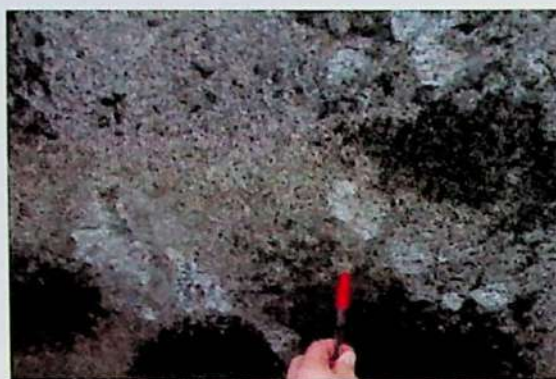
Figura 2: Perda de polimento e destacamento.
