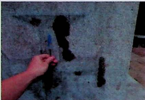
Figura 3: Mancha de umidade.
