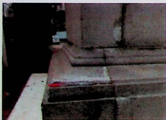
Figura 3: Restauração com argamassa.
