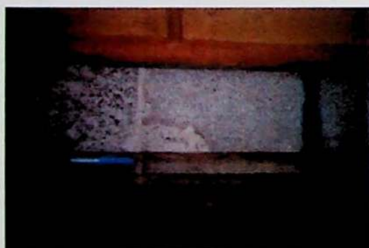
Figura 3: Restauração com argamassa e utilização mesclada .
