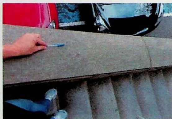
Figura 4: Descoloração por limpeza por jato d' água sob pressão.
