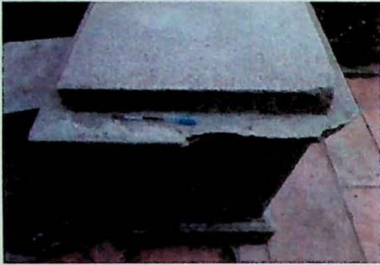
Figura 1: Lacuna e restauração com argamassa.
