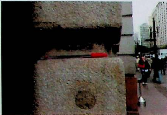
Figura 1: Fratura, restauração com argamassa.
