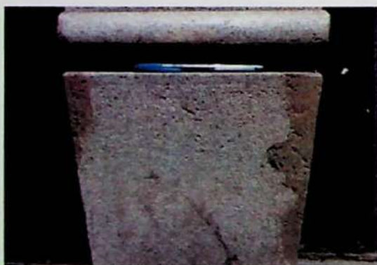
Figura 3: Restauração com argamassa.
