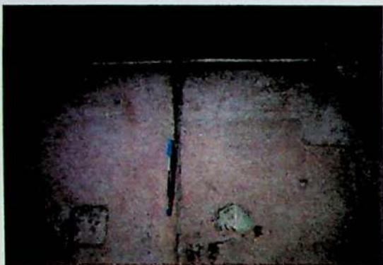
Figura 1: Mancha esverdeada, restauração com argamassa.
