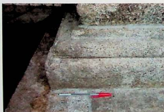
Figura 4: Erosão.
