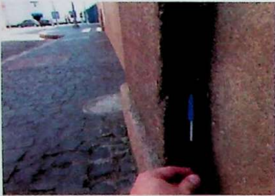
Figura 1: Lacuna e destacamento.
