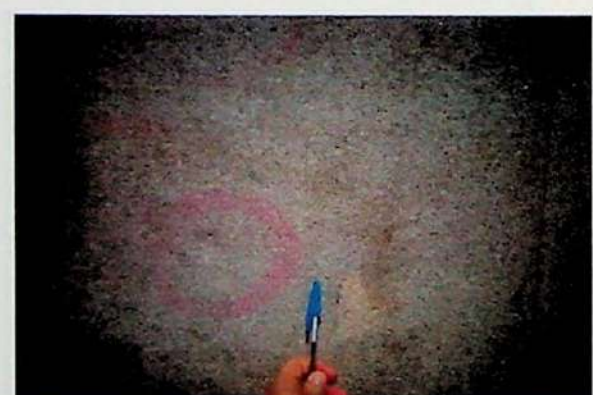
Figura 4: Descoloração por tentativa de remoção de grafite.
