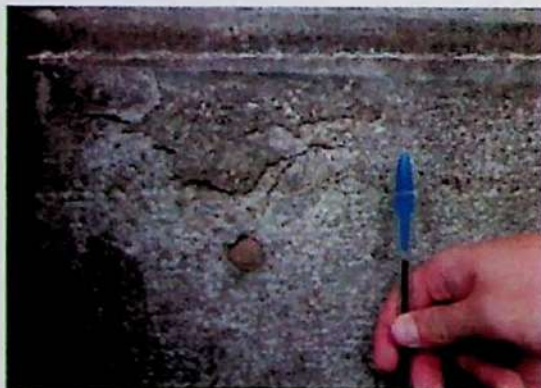
Figura 3: Destacamento e restauração com argamassa.
