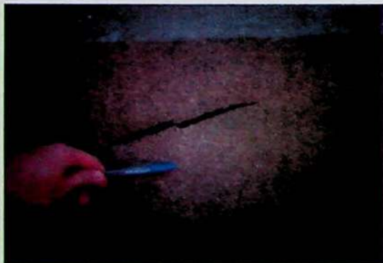
Figura 3: Fissura.
