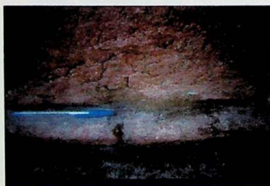
Figura 3: Colonização biológica, destacamento e sujeidade
