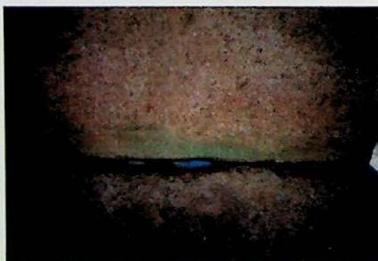
Figura 3: Mancha esverdeada e concreção incipiente.
