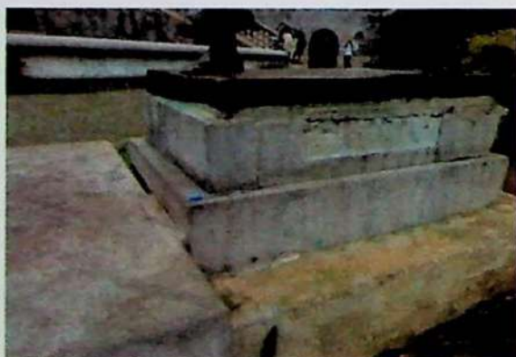
Figura 3: Descoloração por tentativa de remoção de grafite.
