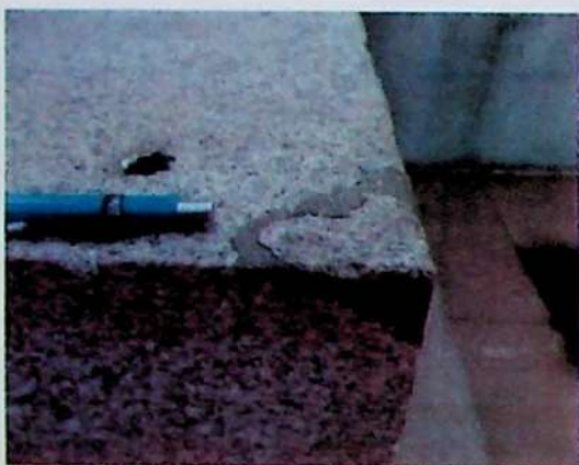
Figura 1: Restauração com argamassa.
