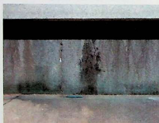
Figura 4: Mancha esverdeada e concreção.
