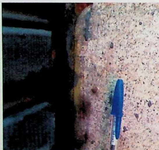
Figura 3: Mancha de graxa, colonização biológica.
