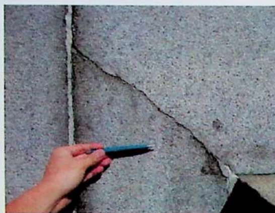
Figura 2: Fratura.
