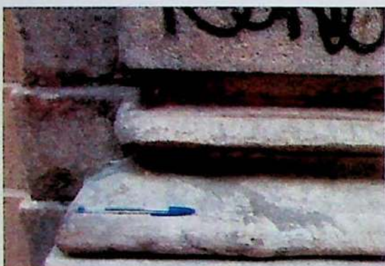
Figura 1: Restauração com argamassa.
