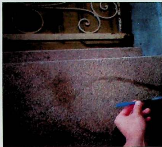
Figura 2: Mancha de umidade e sujeira.
